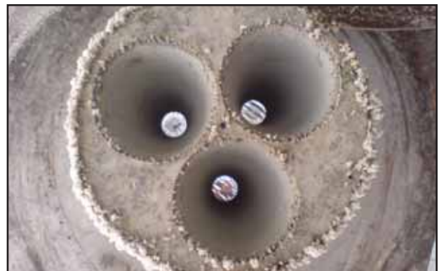
Dentro de la unidad esta limpia y completamente operacional.
